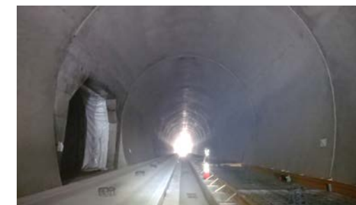
19.国縫トンネル他 坑内状況
