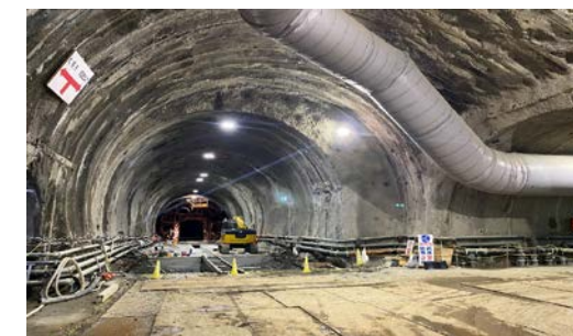
26.羊蹄トンネル(有島)他 シールドマシン組立状況
